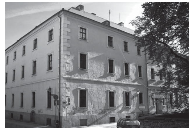
Obr. 3 • Budova stredovekej farskej školy. Fot. K. Deczyński.
